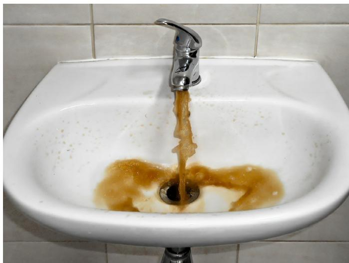
▲ La rouille ou une décoloration noire peuvent être interprétées comme un excès de fer et de manganèse. Ces excès peuvent entraîner des effets secondaires indésirables tels que des blocages dans le système de tuyauterie, un mauvais goût, et peuvent favoriser l'apparition d'un biofilm.
